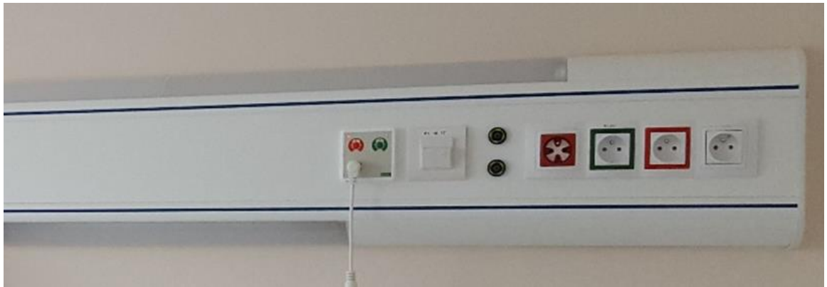
Mitta- ja kalustekuva 1 potilaspaikan paneelista, 1500mm
